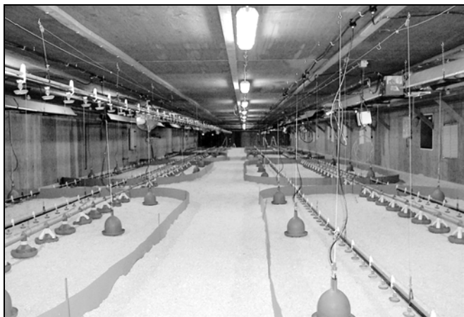
FIGURE 7. Remplacement de lampes incandescentes par un système d'éclairage fluorescent. (Source : Agviro, Inc.)
