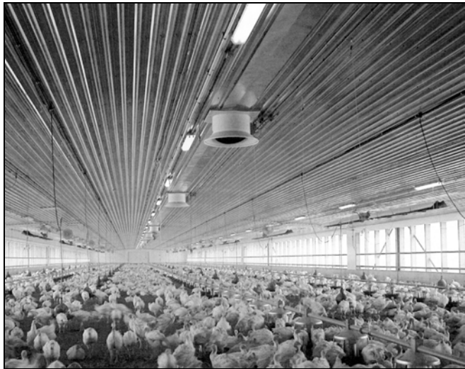
FIGURE 5. Système de tubes fluorescents à intensité réglable dotés de cellules photoélectriques, où deux rangées de lampes sont allumées et une rangée de lampes sont éteintes. (Source : GVA Lighting)
