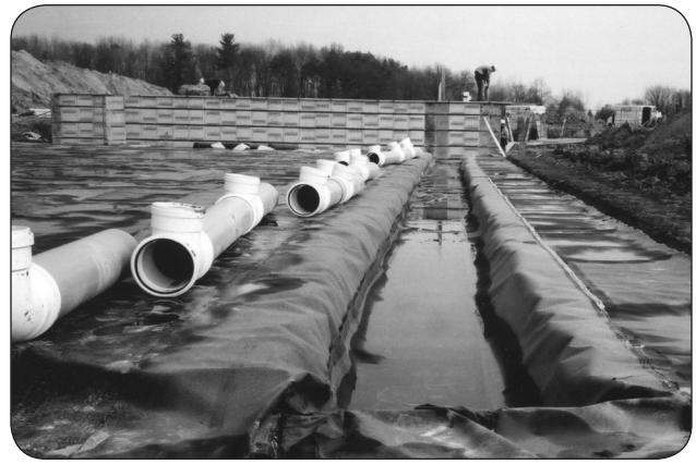
Figure 3. Sections de tuyaux en PVC prêts pour l'assemblage. Les tuyaux formeront un système sûr de transfert de fumier liquide depuis le réservoir situé dans le futur bâtiment d'élevage jusqu'à la structure extérieure d'entreposage du fumier.
