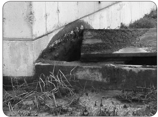
Figure 4. Couvercle de fosse à lisier déplacé par de la mousse s'étant formée dans le lisier.
