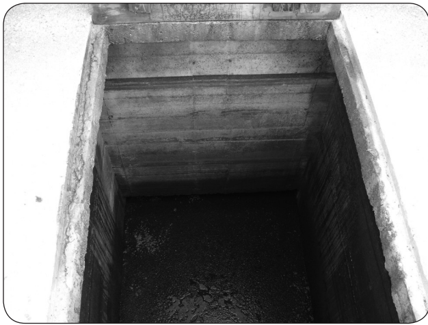
Figure 3. Dans une structure non mise à l'air libre, si la fosse de vidange est dotée d'un déflecteur, l'espace libre se trouvant au-dessus de la surface du fumier se pressurise une fois que le niveau du lisier atteint le bas du déflecteur.
